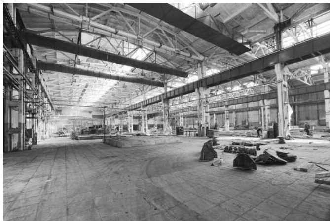
Один из строящихся корпусов Сосновоборского машиностроительного завода
